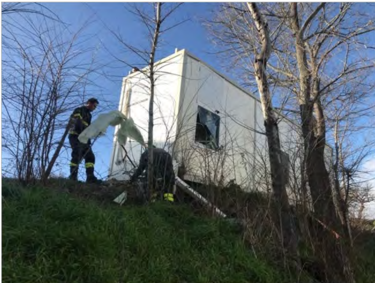
Il modulo che si è rovesciato per il vento
